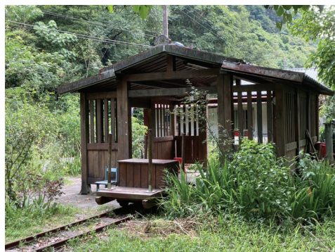
圖 8：復建鹿寮坑車站及手押臺車 （資料來源：筆者攝影 2023.9.21.）
