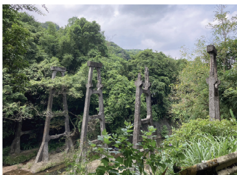
圖 7：鹿寮臺車橋墩 （資料來源：筆者攝影 2023.9.21.）
