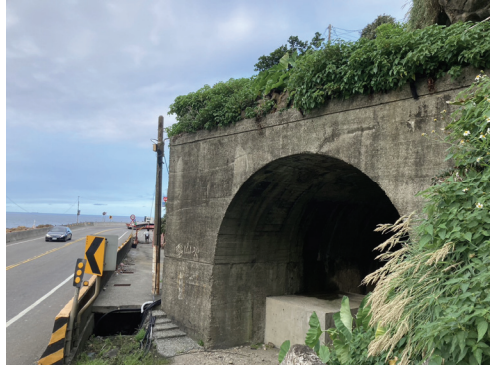
圖 24：濱海公路旁的臺鐵水湳洞廢棄隧道 (資料來源：筆者攝影 2023.9.21.)
