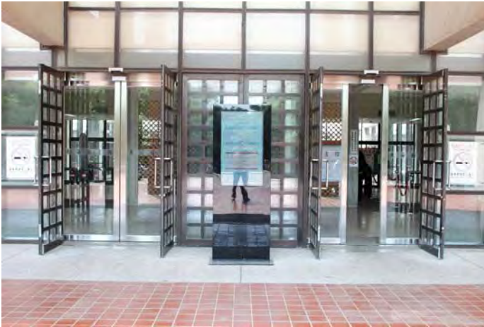
(整建前的大門)
