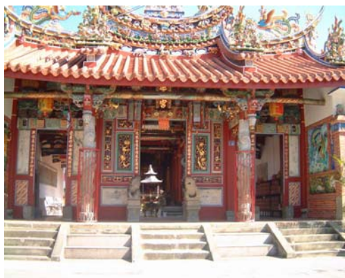
「九二一」震災後重修之正門
