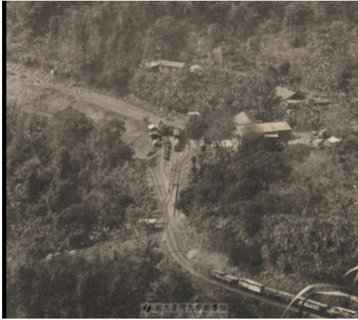
圖 31 獨立山隧道俯瞰樟腦寮驛 （資料來源：臺灣大學）
