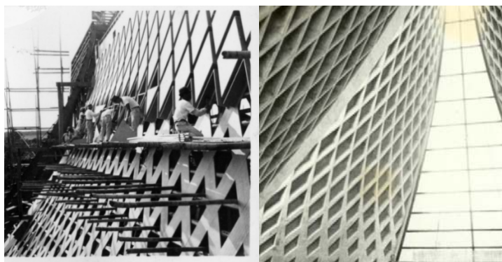
雙曲拋物面的格子樑柱牆合一結構
