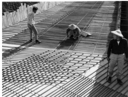
樓面鋼筋網綁
