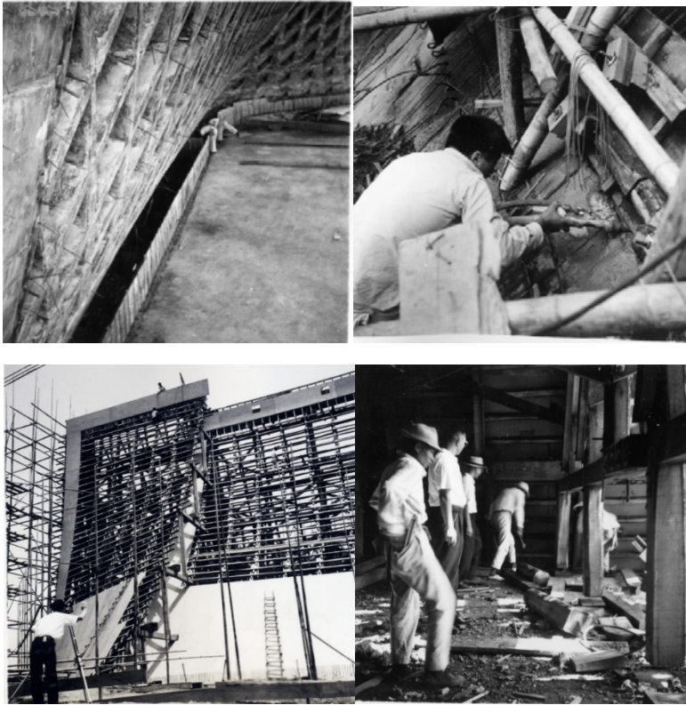
教堂施工照片
