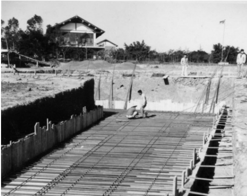
深掘了 2.2 公尺的地基
